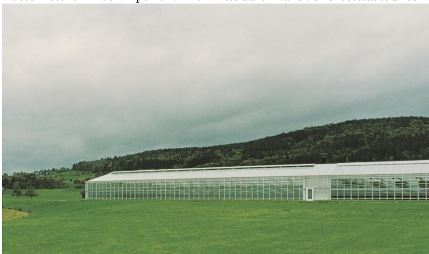
Abbildung 4: Grosse Treibhäuser, aber auch Pouletmasthallen, Remisen und andere landwirtschaftliche Bauten verbrauchen viel Kulturland und fördern die Zersiedelung ©WWF Switzerland
