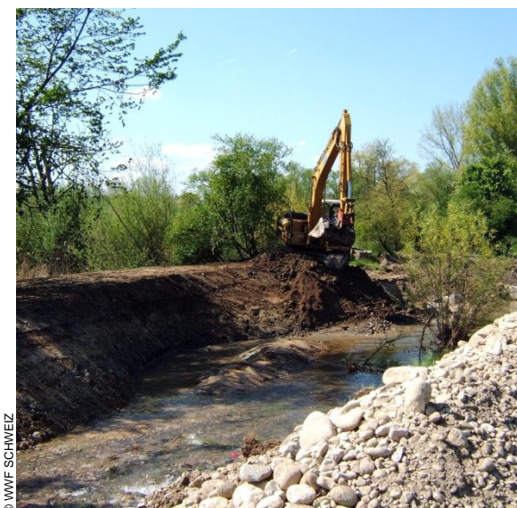
Es entsteht wieder ein naturnaher Bachlauf.
