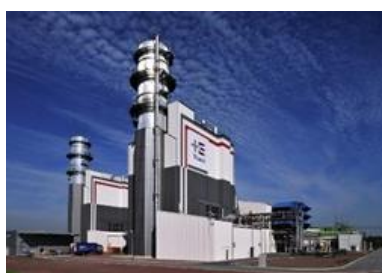
La centrale à gaz et à vapeur d'Irsching (D) (bloc 4) a une puissance de 561 MW et un rendement de 60,4%.
