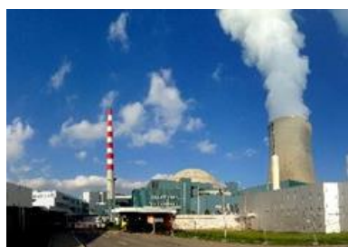
La centrale nucléaire de Gösgen fonctionne depuis 1979 et a une puissance de 1010 MW.
